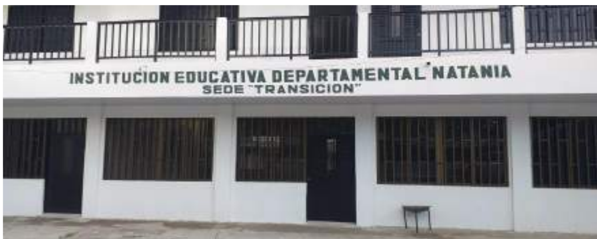
Foto 2. Adecuación y mantenimiento de la sede de Transición Institución Educativa Natania. Fuente: Secretaría de Educación Departamental. Fecha: Noviembre 2023
